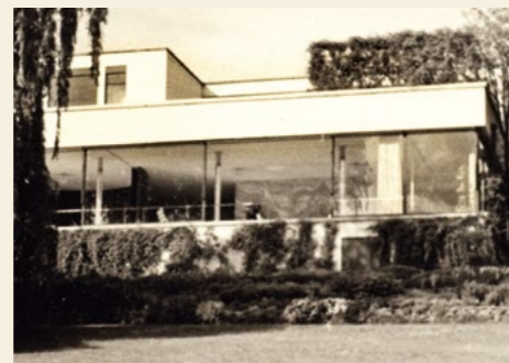
Südfassade. Die Fassade ist im unteren Bereich und auf der Terrasse von Vegetation bedeckt (Knöterich). Nach den Zeichnungen von Ludwig Mies v.d.R. war dies von Anfang geplant.
