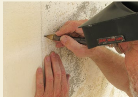
Ostwand der oberen Terrasse, Detail: Ivo Hammer bei der Reinigung der Oberfläche mit Hilfe eines pneumatischen Mikro-Meißels und einer Lupe.
