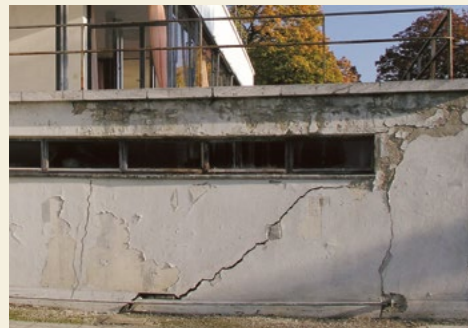
Gartenterrasse von Westen. Der große Riss ist durch ein undichtes Abflussrohr verursacht, was zur Instabilität einiger Pfeiler und ihrer Brunnenfundamente führte.
