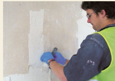
Obere Terrasse, Nordost-Ecke, Blick auf den Bereich der Pilotarbeit (ca. 8 qm). Michael Pech (Art Kodiak) während der Abnahme einer Ammoniumcarbonat-Kompresse. Die durch Luftverschmutzung entstandene Gipskruste wird chemisch entfernt.
