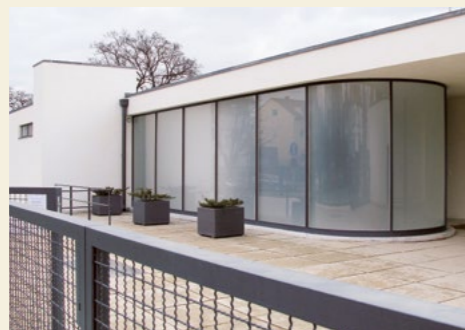
Nordfassade, nach Restaurierung. Die rekonstruierte Glaswand des Eingangsbereichs ist an der Innenseite durch Ätzung mattiert.
