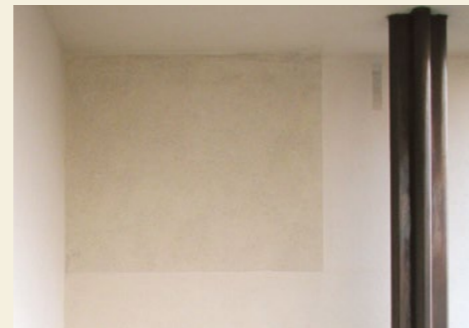
Ostwand der oberen Terrasse. Archaisches Fenster (ca. 1 qm) der ursprünglichen Fassadenoberfläche. Die Kalktünche entspricht im Material dem Originalbestand, ist aber heller, weil Kalk bei der Alterung nachdunkelt.
